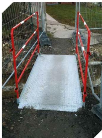
Passerelle en tôle acier galvanisé avec garde-corps standard, blanc et rouge, emboîtable Ø 25 mm, hauteur 1,00 m et rampe d'accès fixe (tôle recourbée).
