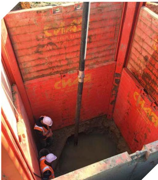
**Puit 3,5 m x 3,5 m à 4,7 m de profondeur**
