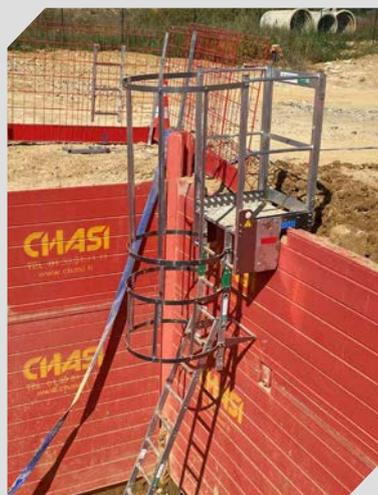
Echelle à crinoline avec module d'arrivée encastrable sur les panneaux de blindages.
