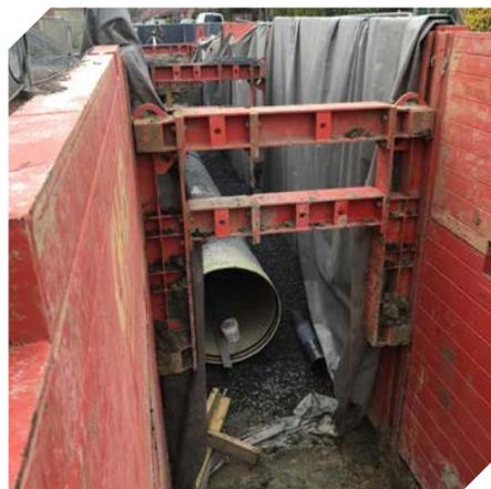
Le blindage coulissant est composé de panneaux (bases et rehausses) qui sont à coulisser dans des poteaux (droits ou d'angles).
